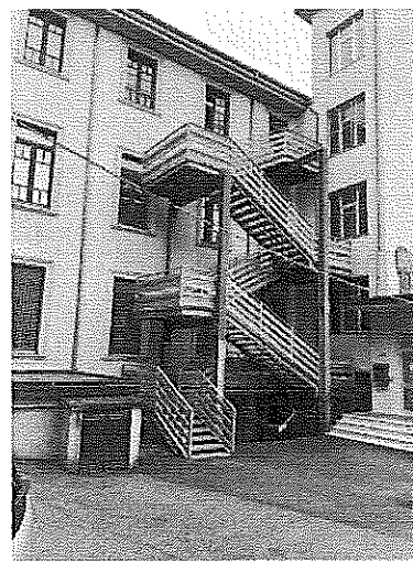
Scala di emergenza lato ovest
